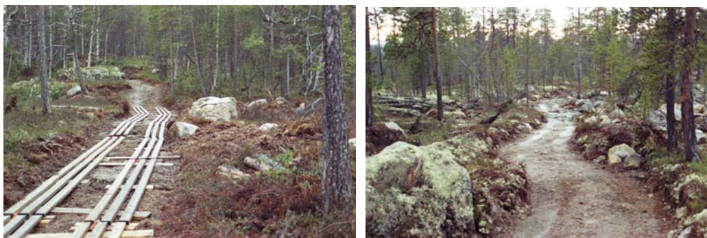
Figur 4. Kjøretraséen er opp til 2.5 meter bred. Steinblokker er lagt i hauger og voller langs med veitraséen. Foto: FIR og NINA
